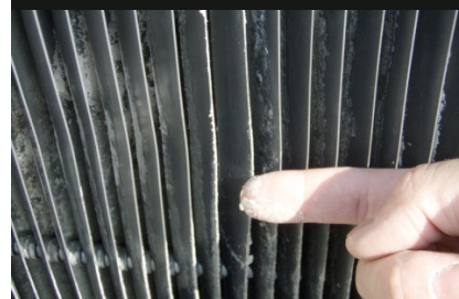
Il était impossible d'éliminer la silice avec le pistolet à eau haute pression, mais la silice restante pouvait être enlevée avec un doigt.
