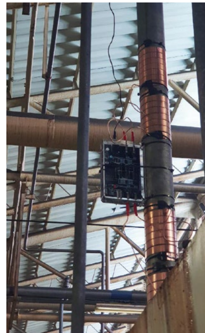
Vulcan S25 a été installé à quelque 50 mètres en amont de la machine de trempe par induction.
