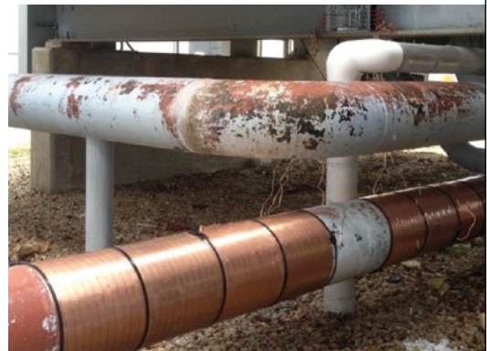
Vulcan S250 a été installé sur une ligne de 10 pouces de diamètre servant à alimenter les deux tours de refroidissement (CT-1 et CT-2)
